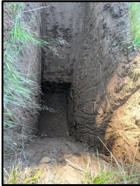
Test Pit, TP-6
